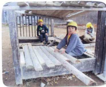
家がだんだんできていくと、2階へ上がるための板を立てかける
